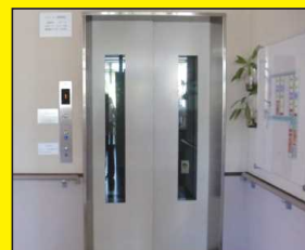
エレベーター
